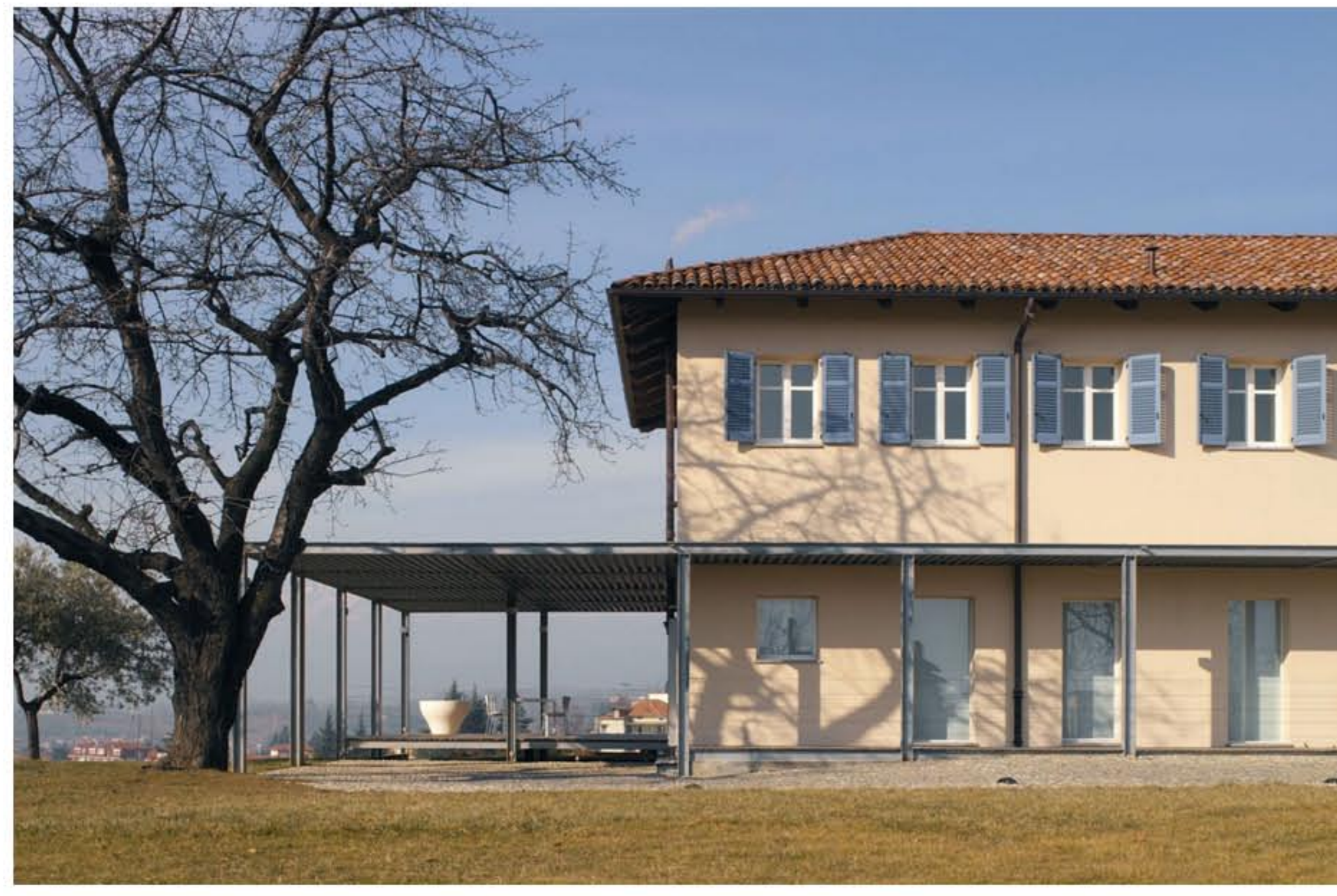
⊕ La cascina ristrutturata ha mantenuto il suo carattere originale. La nuova struttura in ferro zincato che copre i portici e la terrazza è l'elemento di un intervento moderno più evidente.
